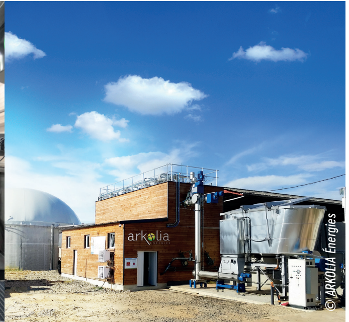
↗ Unité de méthanisation en voie épaisse Arkométha® Napagèse - ARKOLIA Énergies
